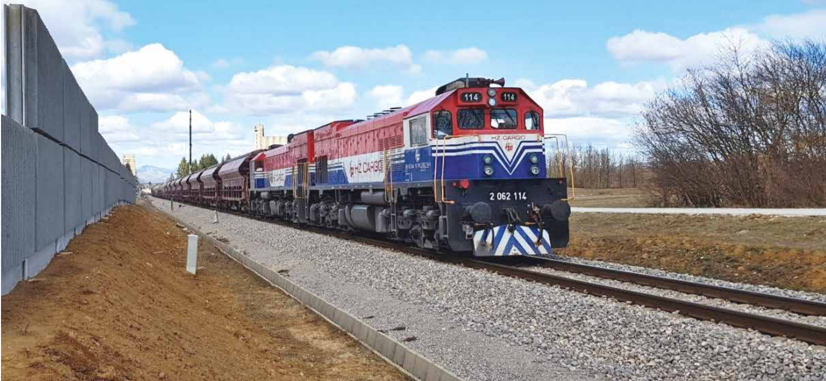
Izgrađena zaštita od buke kod kolodvora Gospić
